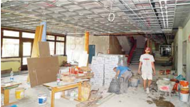
Während der Bauarbeiten ...
