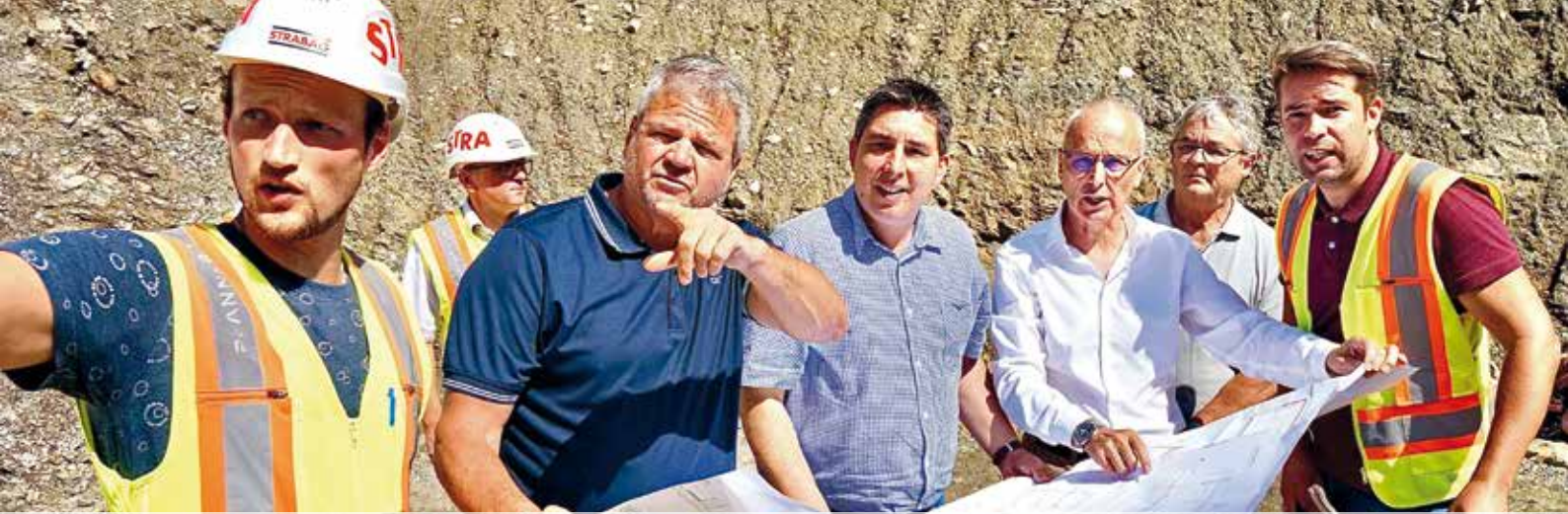
(von links): Bautechniker Marco Grutschnig (Strabag), Bürgermeister Gerhard Köfer, Stadtrat Christoph Staudacher, Abteilungsleiter Berthold Uggowitzner (Stadt Spittal), Gottfried Berger (Bauleiter ZT-Büro Passer & Partner) und Bauleiter Werner Pirker (Strabag)
