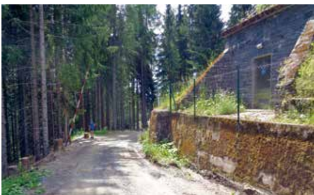
Bei Eckberg-Kreuz wird neben dem bestehenden Behälter ein neuer Hochbehälter errichtet.
