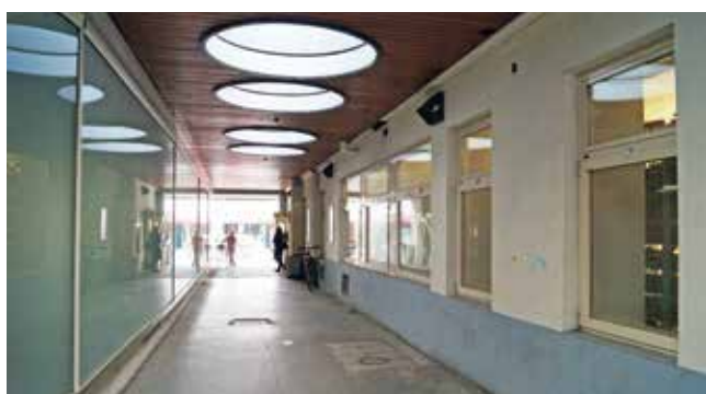
Die Grebmergasse vor den Umbau-Maßnahmen
