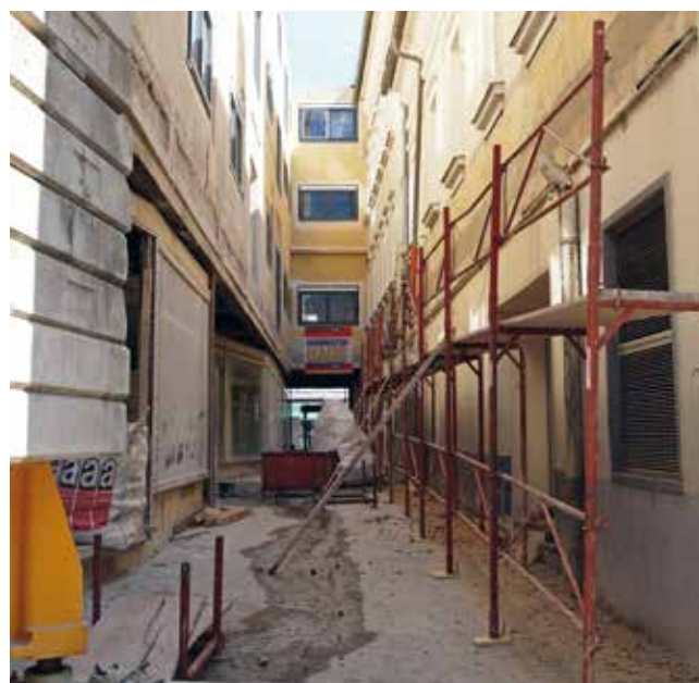
Im April wurde die Überdachung abgebrochen
