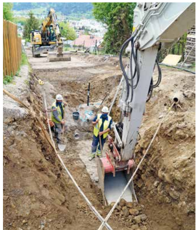
Bauarbeiten im Bereich der Höhenstraße mit entsprechenden Schutzmaßnahmen
