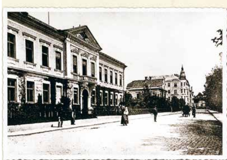
Die 1903 errichtete Amtsgebäude der Bezirkshauptmannschaft Spittal
