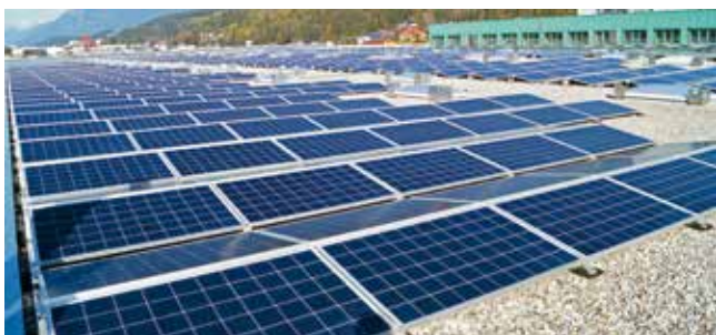
Am Dach wurde eine Photovoltaik-Anlage mit einer Leistung von 1,3 Megawatt errichtet
