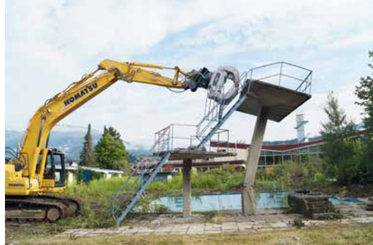
Abbruch des alten Sprungturms
