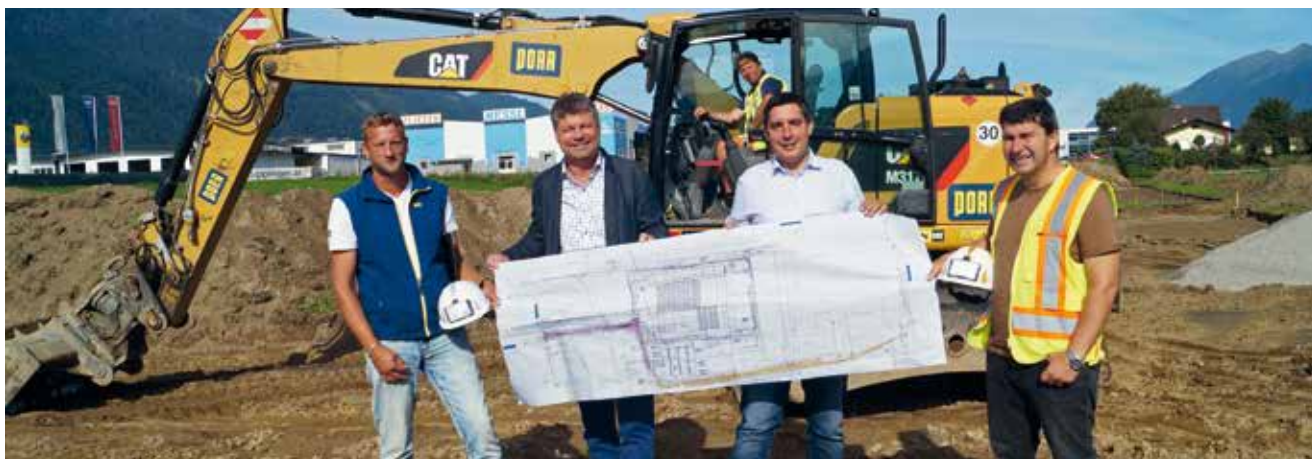
Baustart der wichtigen Infrastruktur-Maßnahme (von links): Johann Kogler (Polier Baufirma Porr), Bürgermeister Gerhard Pirih, Stadtrat LAbg. Christoph Staudacher und Wilhelm Unterdorfër (Planungsbüro Passer & Partner)
