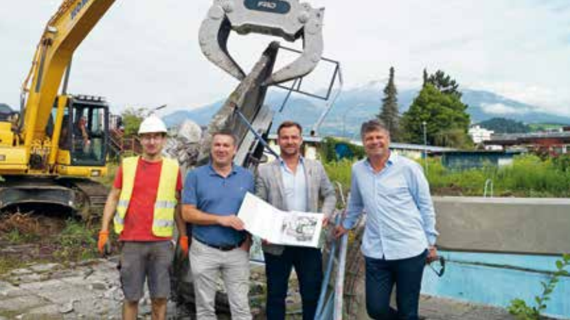
Florian Außerwinkler, Vizebgm. Andreas Unterrieder, Christian Moser (Bauamt Stadt Spittal) und Bgm. Gerhard Pirih (Baggerfahrer Peter Stranner)
