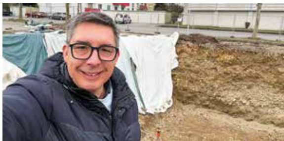
Die große Versickerungsanlage in der Gartenstraße
